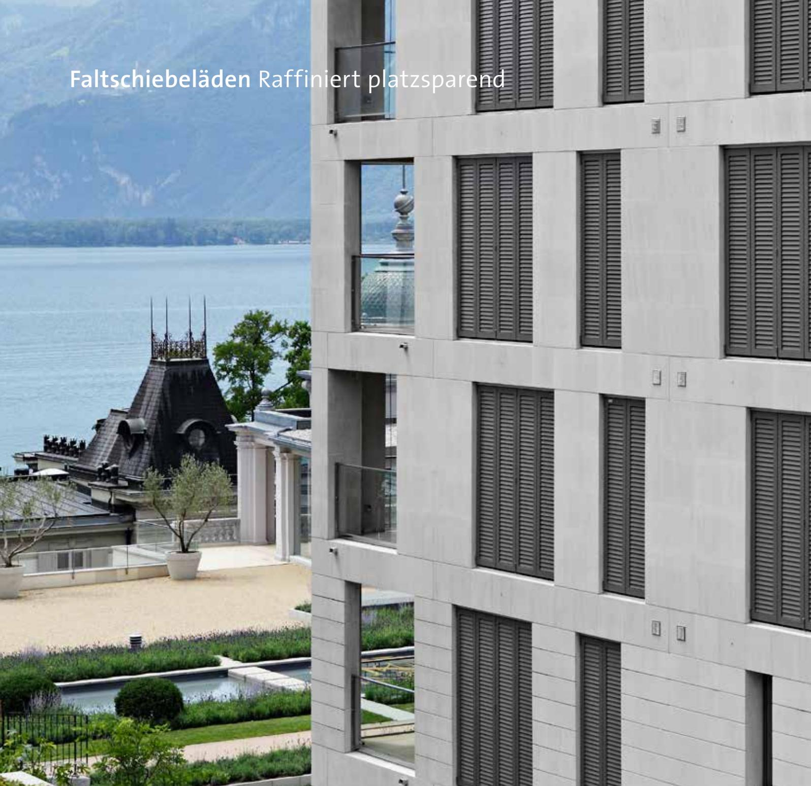
Faltschiebeläden werden wie eine Ziehharmonika platzsparend und ohne großen Öffnungsradius geöffnet und geschlossen. Die offenen Läden werden an der Fassade zurückgehalten. Darüber hinaus ermöglichen sie ganz neue Perspektiven der Fassadengestaltung.
